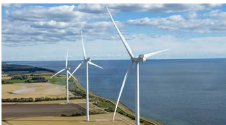
Windpark Mads, Dänemark Near-Shore Windpark mit 7 Turbinen Neuerrichtung in 2017
